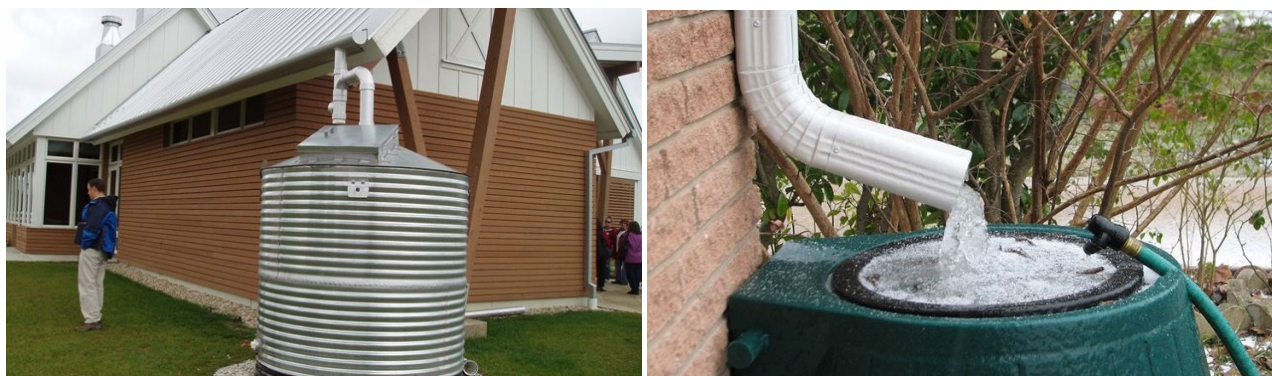
Figure 4.8: esempi di sistemi di raccolta individuali tratti dalle “Schede tecniche” delle “Linee guida e indirizzi operativi per l’attuazione del principio della invarianza idraulica”.
